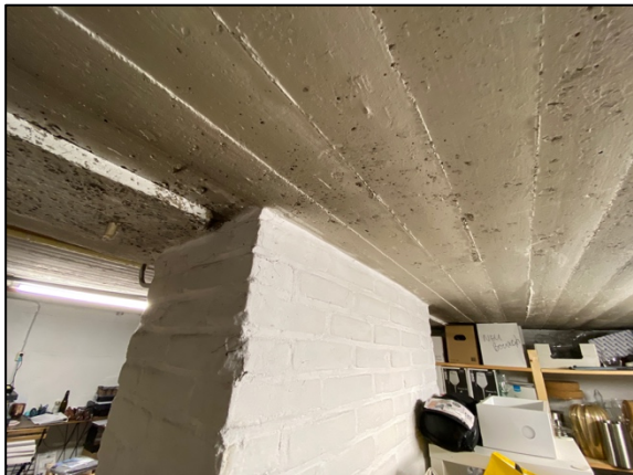
kelder, detail plankenbekisting betonvloer
