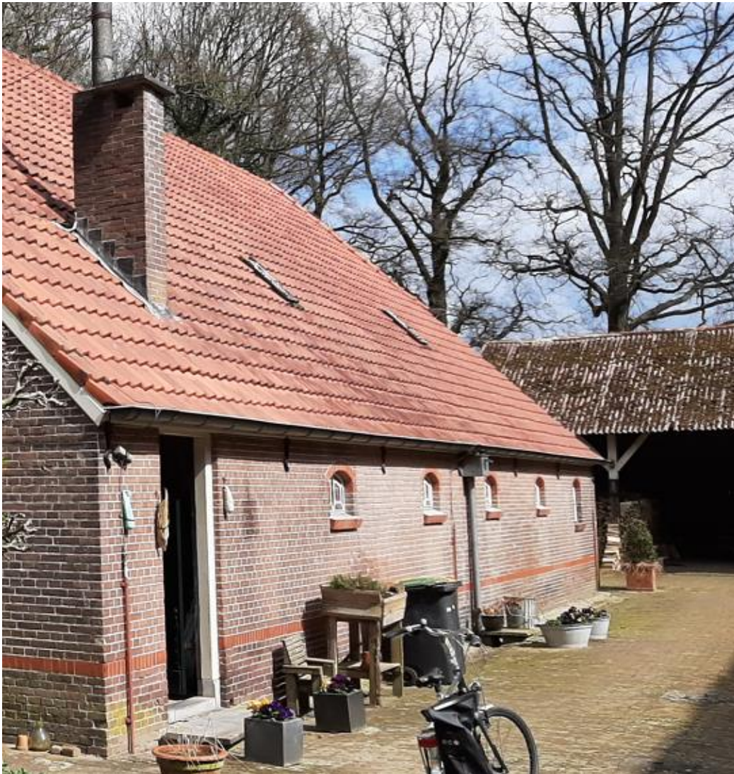
Figuur 41: Zuidgevel bijgebouw
