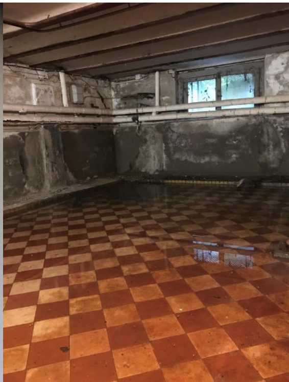
Figuur 36: Noordelijke kelder
