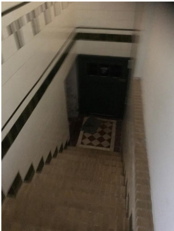
Figuur 35: Trap naar kelder
