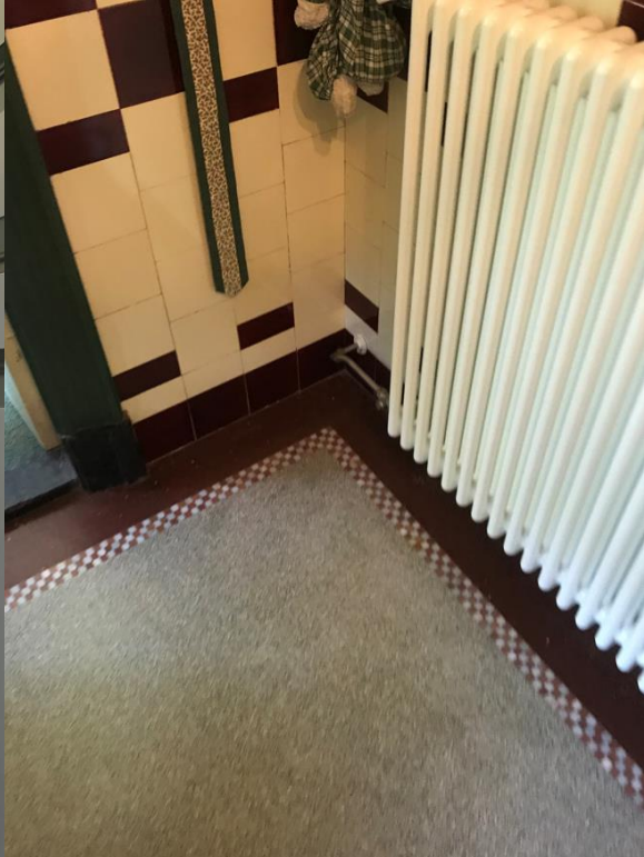
Figuur 14: Originele vloer
